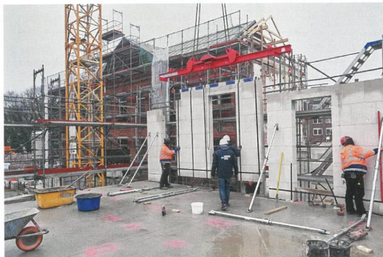
Die Verwendung von Kalksandstein für Außen- und Innenwände bietet zahlreiche Möglichkeiten, die zu einem einfacheren, qualitativ hochwertigen und wirtschaftlichen Bauwerk führen. Der Wandbildner ist robust und langlebig, weist eine hohe Tragfähigkeit sowie Speichermasse auf und besitzt höchste Schall- und Brandschutzeigenschaften. Zudem ist das präzise Material einfach zu verarbeiten und kann zu verkürzten Bauzeiten beitragen. Auch aus ökologischer Sicht
