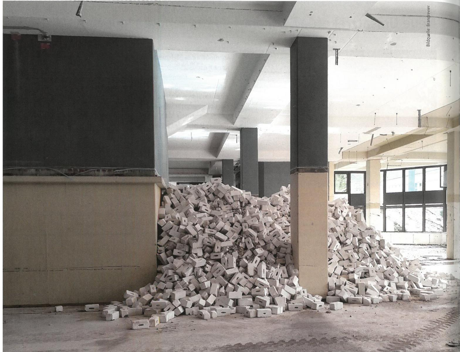
Die rückgebauten Kalksandsteinwände im Untergeschoss des Gebäudes werden durch den KS-Hersteller Cirkel auf ihre Recyclingfähigkeit geprüft. Um die Sortenreinheit des Materials sicherzustellen, mussten die Kalksandsteine nach Abbruch von den übrigen Baustoffen getrennt und separat gelagert werden.
